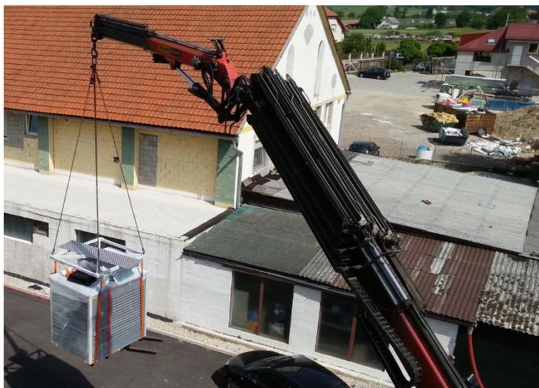
Устройства с более высокой мощностью управляются так же, как и с меньшей мощностью (описанные выше), но используемая транспортная рама больше, и используется дополнительный ремень и U-профиль (рисунок ниже).
